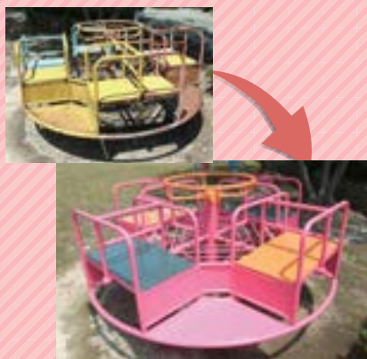
西新町 遊具の修理・塗装
